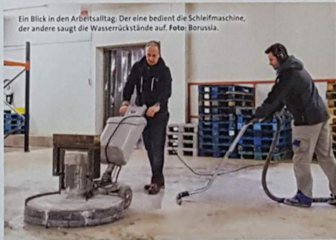
Ein Blick in den Arbeitsalltag: Der eine bedient die Schleifmaschine, der andere saugt die Wasserrückstände auf. Foto: Borussia.
